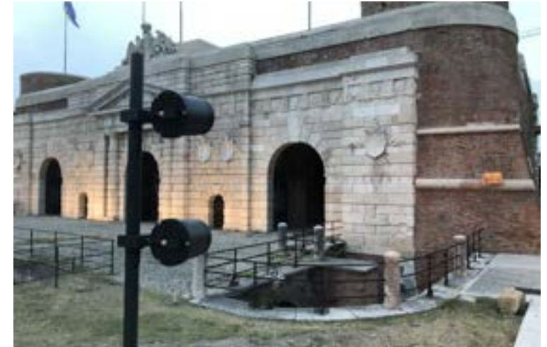
retrofit interventi mirati su impianti esistenti, continuità garantita
